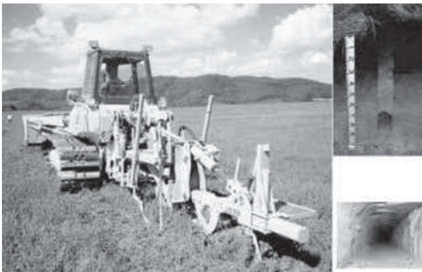
写真-1 カッティングドレーン施工状況と土壌断面
