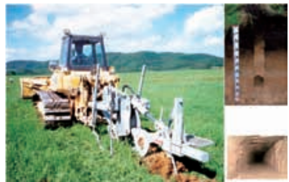
カッティングドレーン施工状況と土壌断面（58ページ参照）
