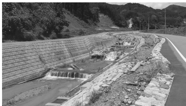
復旧工事が終わった乙石川
