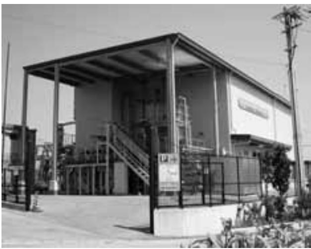
した実証試験を行なった（2006～2010年：農林水産省、経済産業省、環境省、内閣府との連携プロジェクト）。プラントは一連の複合生産工程（砂糖生産～エタノール生産まで）で構成され、原料処理量として1 t/d（国内製糖工場の1/500～1/2000のスケール）である。
