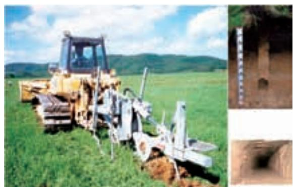
カッティングドレーン施工状況と土壤断面（58ページ参照）
